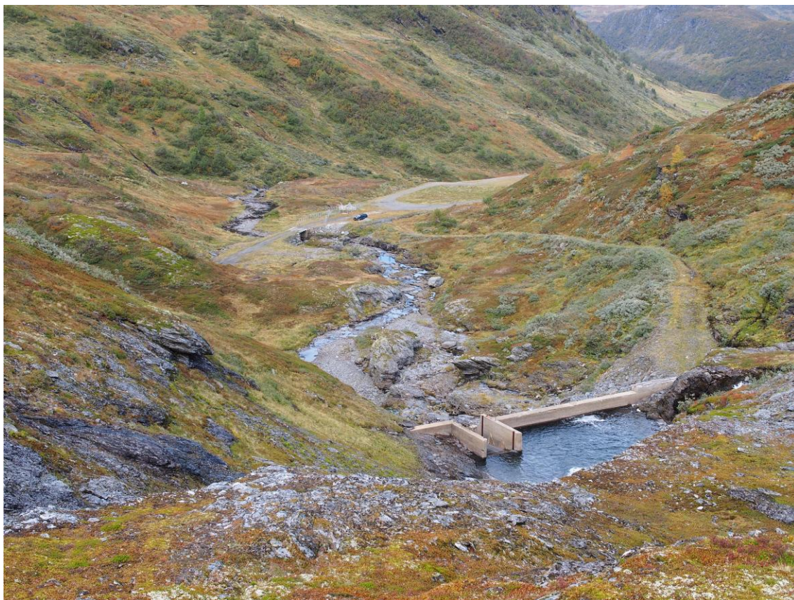
Figur 2.2 Bekkeinntaket i Ygnisdal
