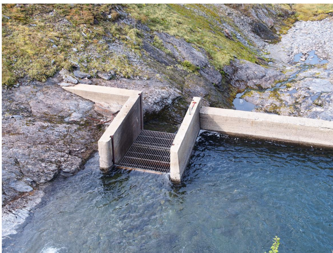
Figur 3.6. Bekkeinntaket ved planlagt kraftstasjon
